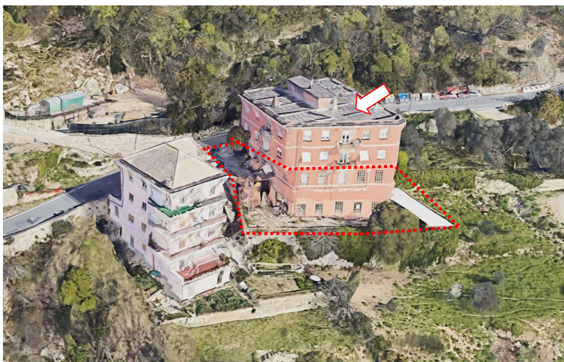
Vista sud del bene oggetto di stima e del terrazzo soggetto a diritto di sopraelevazione
